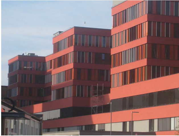
Neubau Klinikum Offenbach am Main 434
